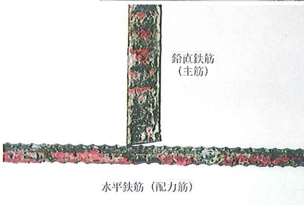
セパ穴よりウレタン樹脂を注入 → 主筋、配力筋、コールドジョイントに材料を充填
